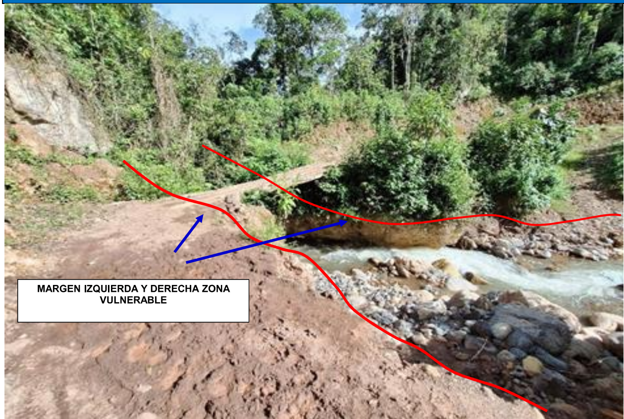
FIGURA N° 01: TRAMO CRÍTICO EN EL SECTOR SANTA ROSA, CASERIO DE TORRE JIRCA, DISTRITO DE CHAGLLA, PROVINCIA PACHITEA DEPARTAMENTO DE HUÁNUCO, AFECTACIÓN CONSTANTE AL PUENTE SANTA ROSA DEBIDO A LA EROSIÓN Y DESBORDAMIENTO DEL RIO TINGO.
